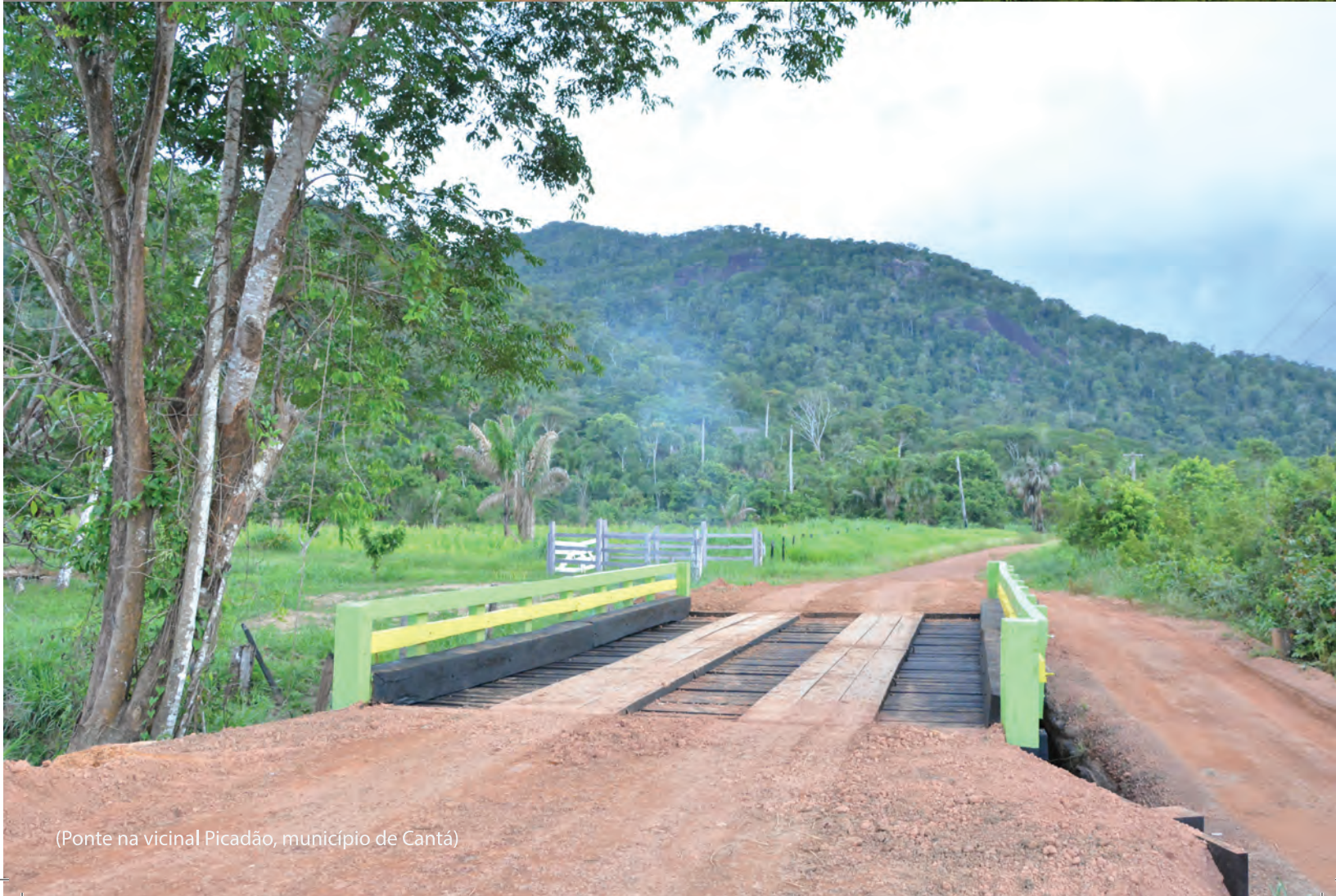
(Ponte de 80m, sobre o rio Quitauaú, na estrada Tronco/Malacacheta, município de Cantá)
