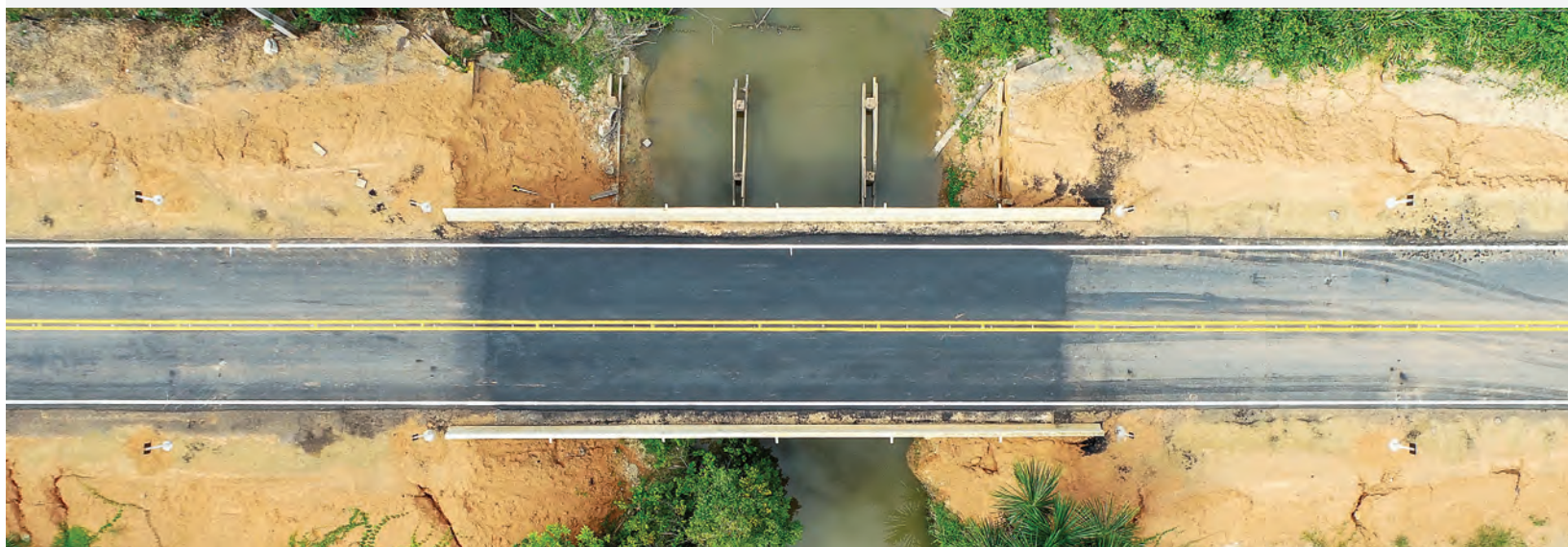
(Ponte na RR 325, entre Alto Alegre e Mucajaí)
