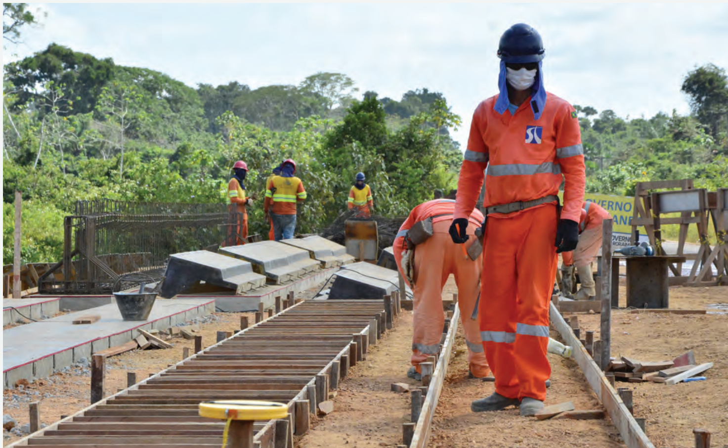
(Trabalhador na obra da ponte de concreto da RR-325)
