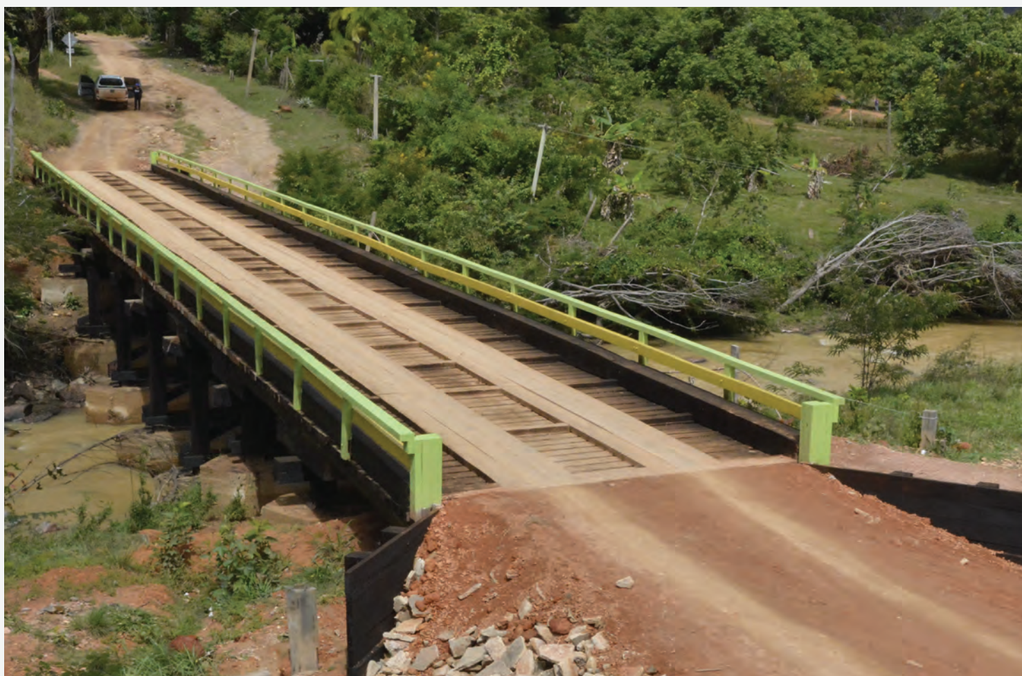
(Ponte sobre o Igarapé Água Fria, Uiramutã)
