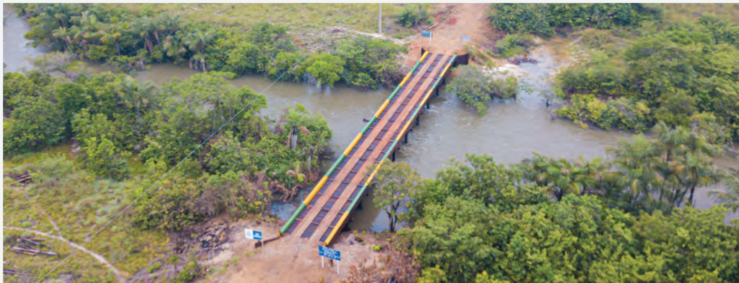
(Ponte sobre o igarapé Xumina, Normandia, entregue em junho de 2023)
