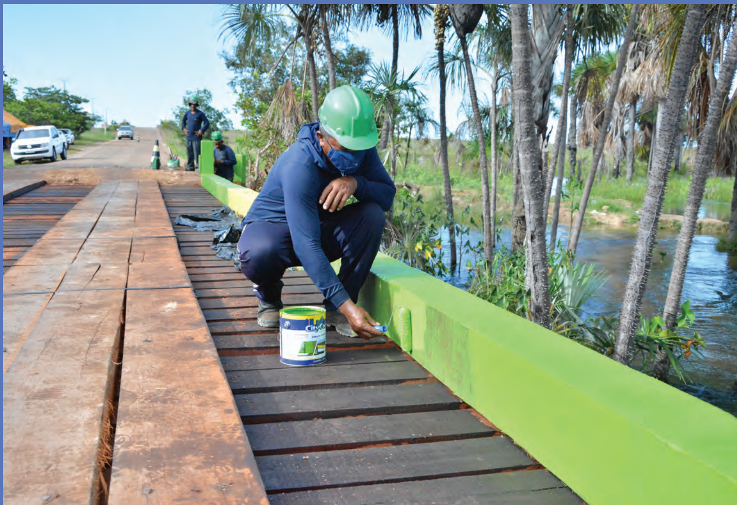
(Ponte na RR-319, na região do Passarão, em Boa Vista)
