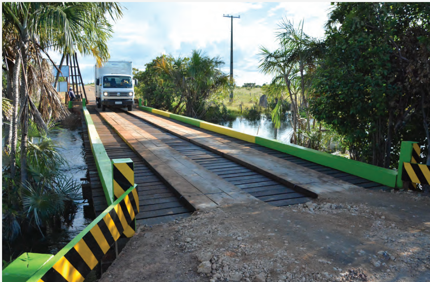
Ponte localizada na RR-319, Passarão, Boa Vista.
