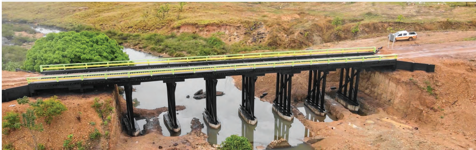
(Ponte de 40 metros sobre o Igarapé Márcio Nogueira, Uiramutã)
