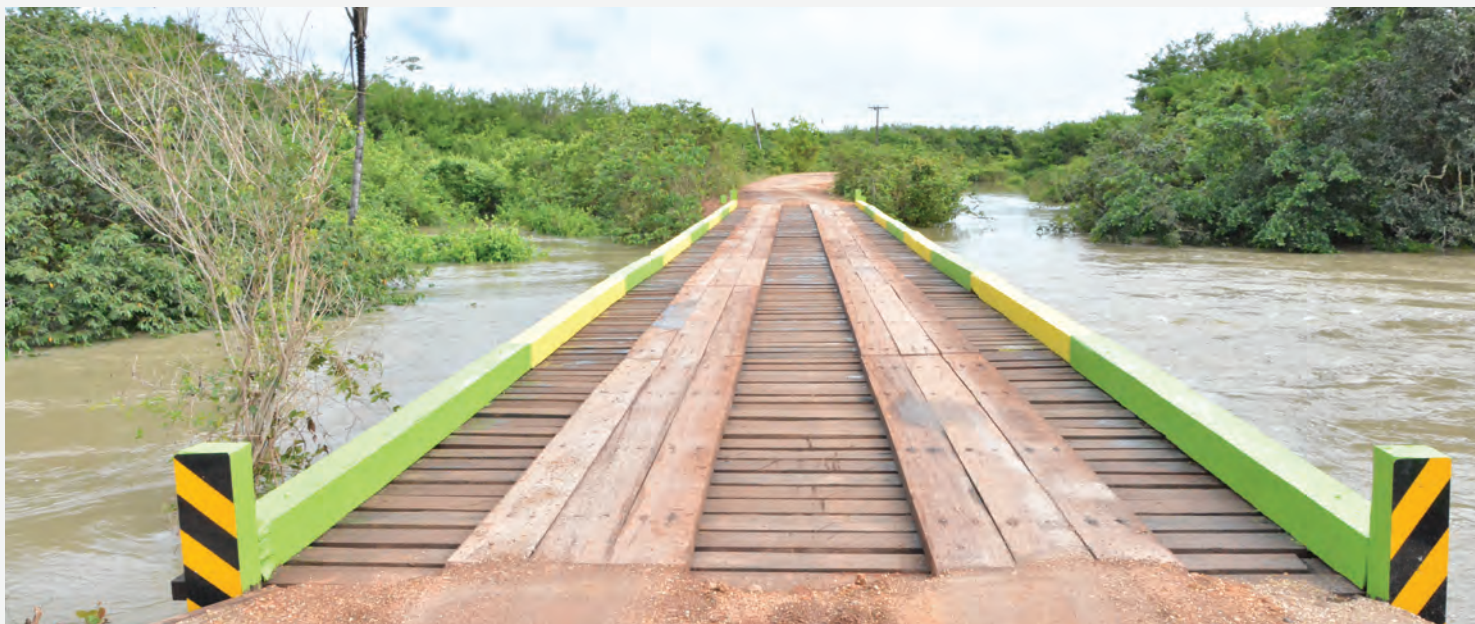
(Ponte sobre o rio Acará, vicinal Ouro Fino, Amajari)
