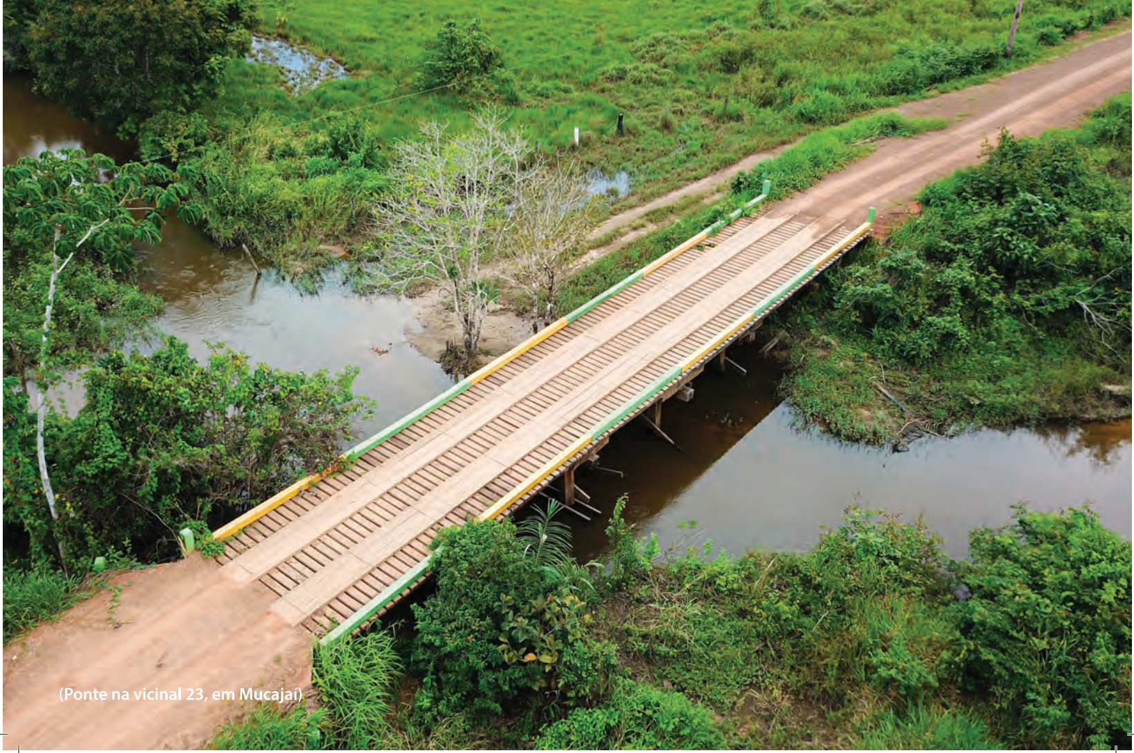
(Ponte na vicinal 11, em Mucajaí)
