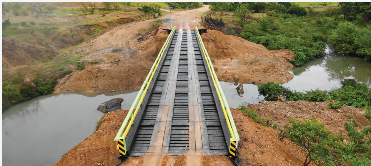
(Ponte de 40 metros sobre o Igarapé Márcio Nogueira, Uiramutã)
