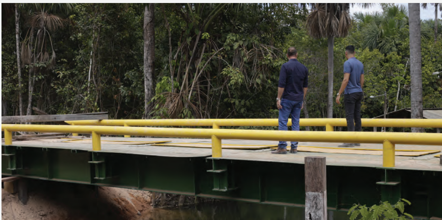
(Pontes móveis instaladas em viciniais e estradas estaduais em Alto Alegre)
