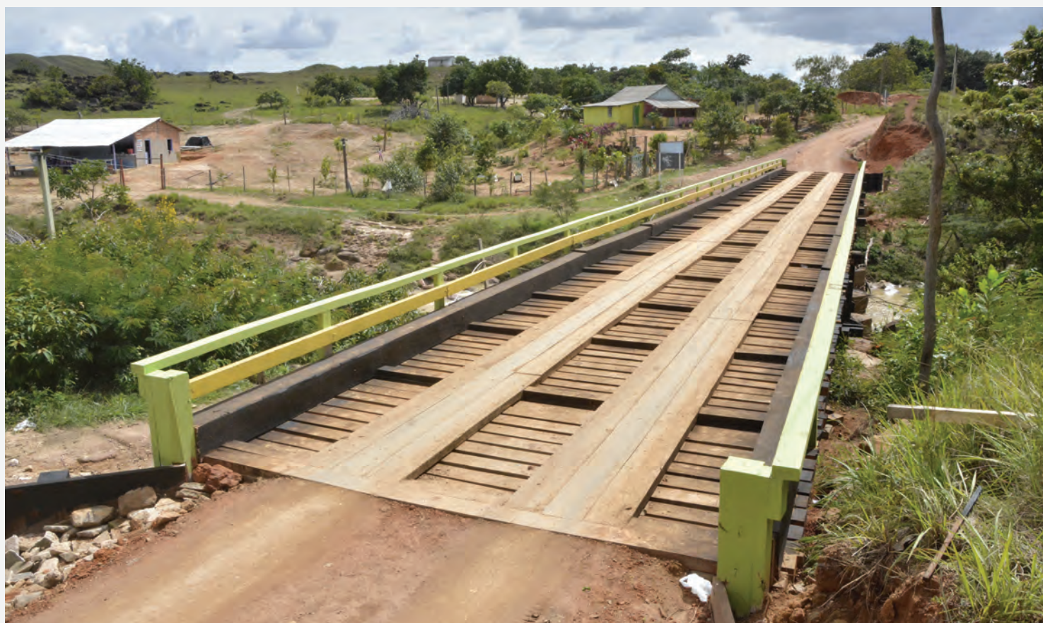
(Ponte de 50 m sobre o igarapé Água Fria, Uiramutã)
