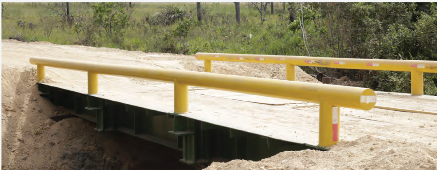
(Pontes móveis instaladas em viciniais e estradas estaduais em Alto Alegre)
